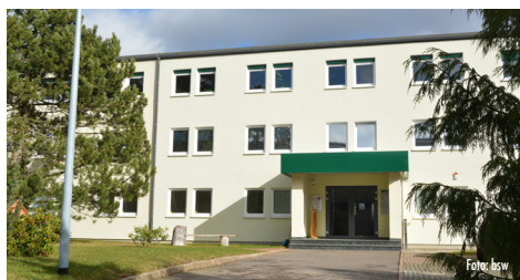
Das neue Bildungszentrum Freiberg auf der Halsbrücker Str. 34
